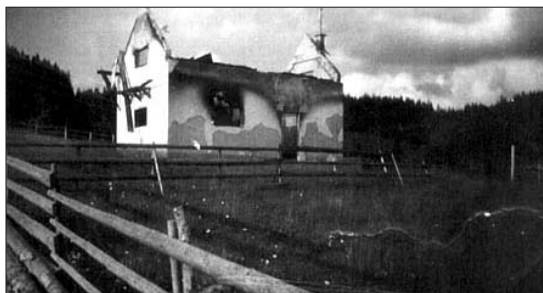
Spaljena kuća crnogorskog građanina Nasera Dacića
