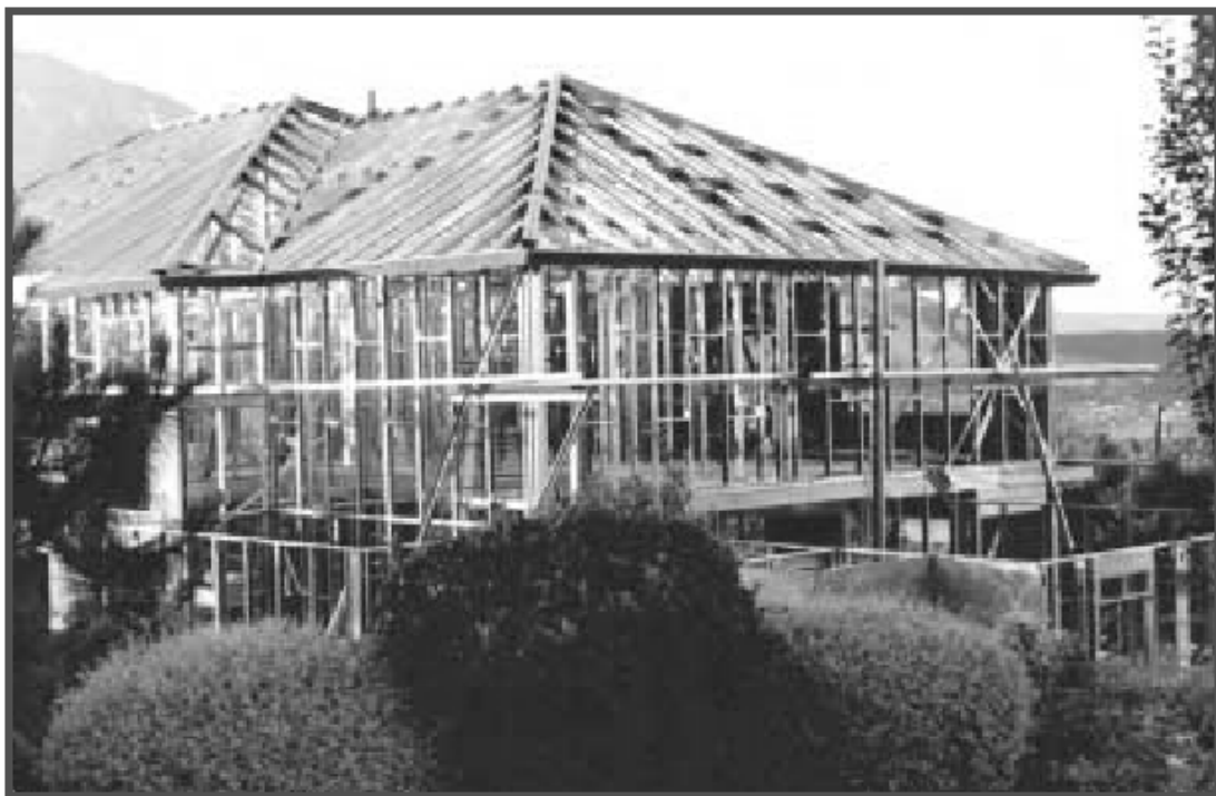
Figura 1.1 Construcción con el sistema de acero laminado en frío.
